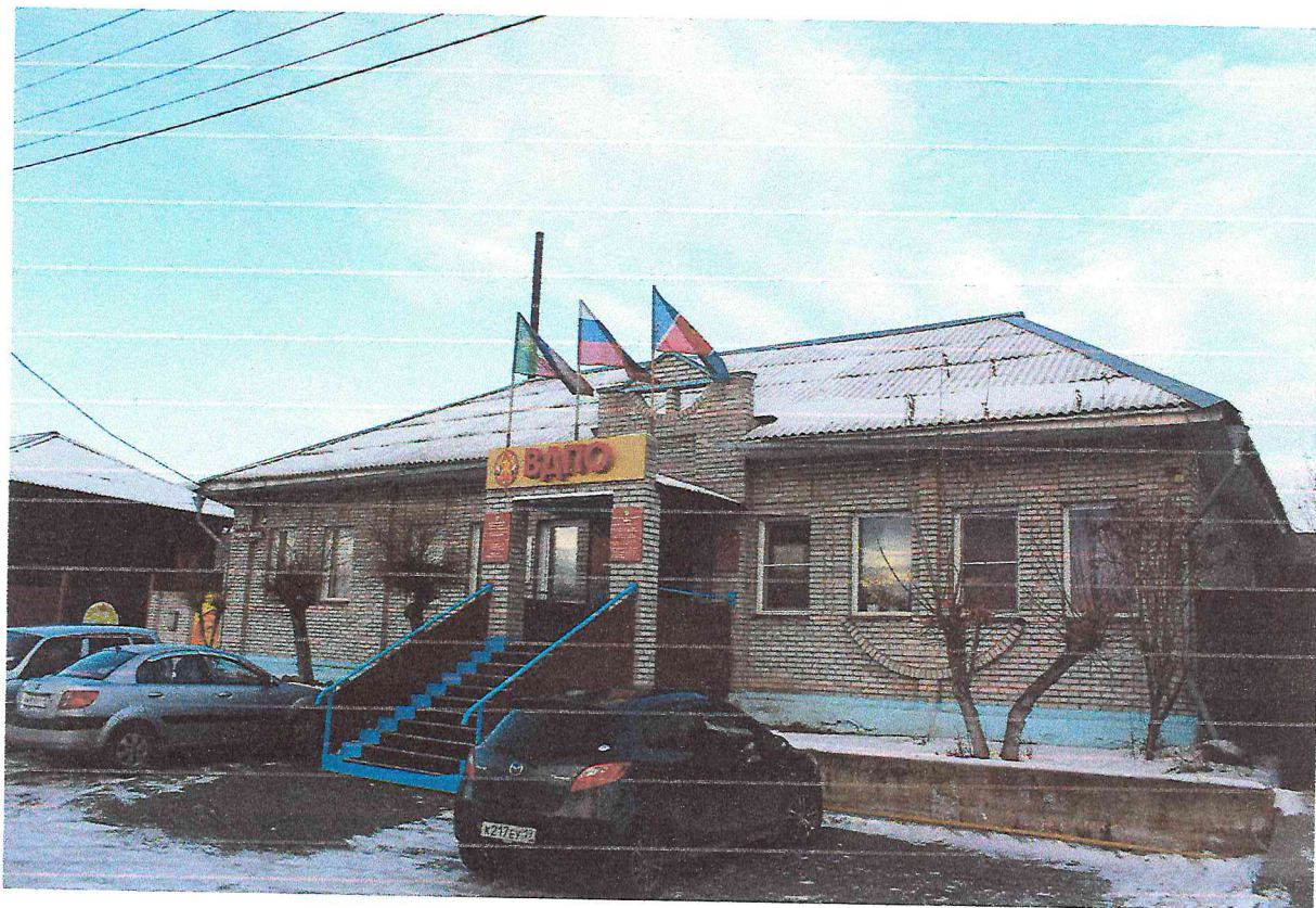
Фото 1. Общий вид лицевого фасада объекта культурного наследия лицевого фасада.
