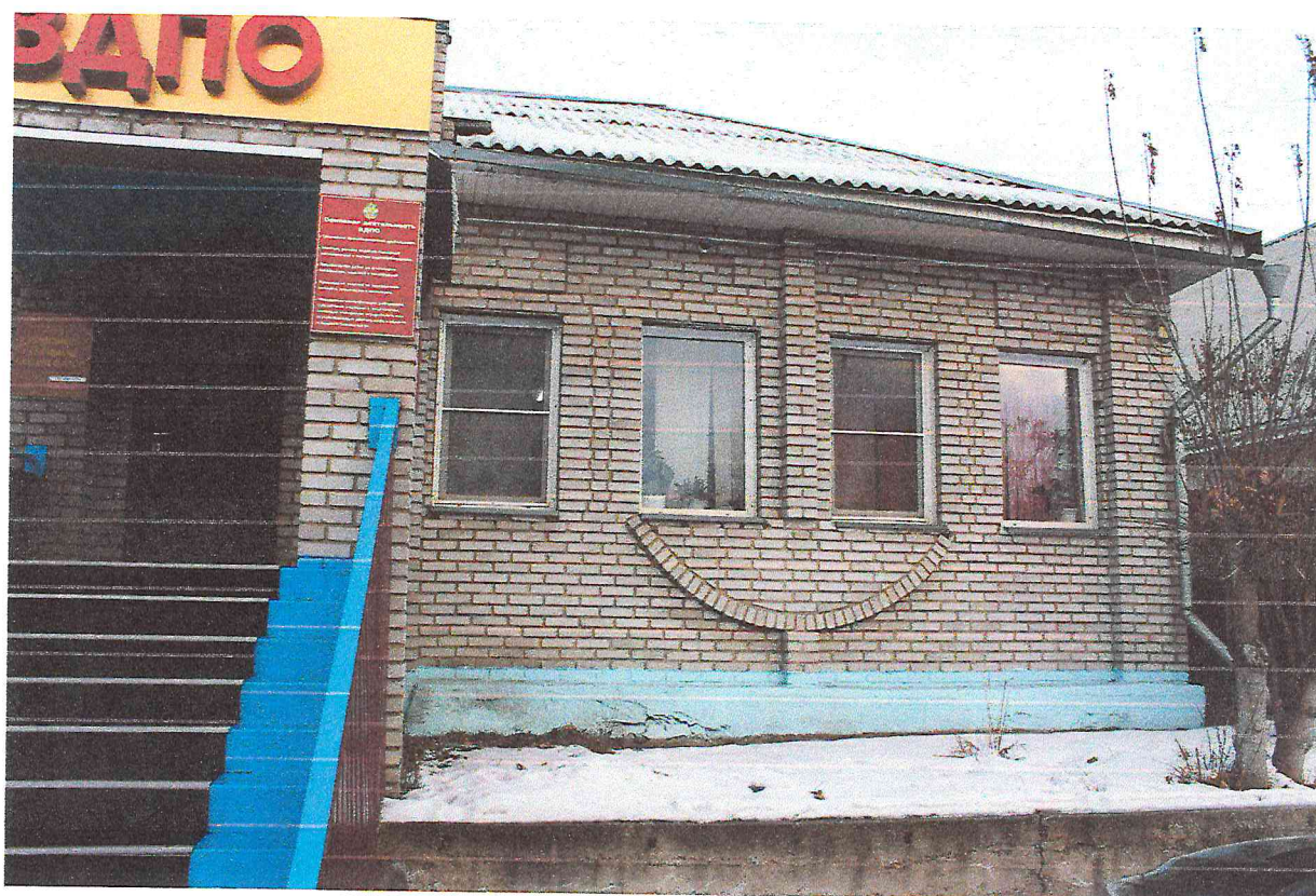
Фото 4. Фрагмент лицевого фасада объекта культурного наследия, вид с юга.
