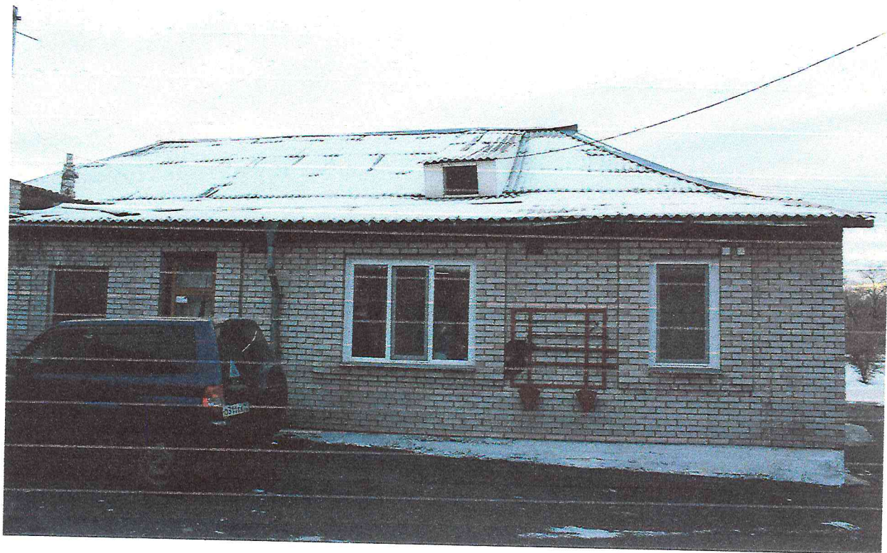
Фото 10. Общий вид северного фасада объекта культурного наследия.
