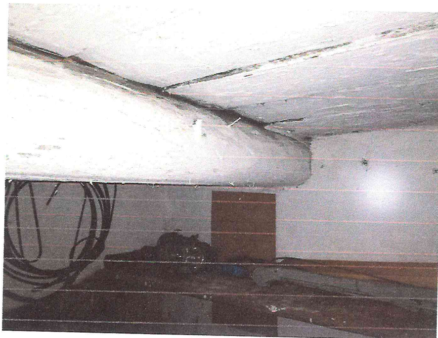
Фото 15. Подвальное помещение. Балочное перекрытие.
