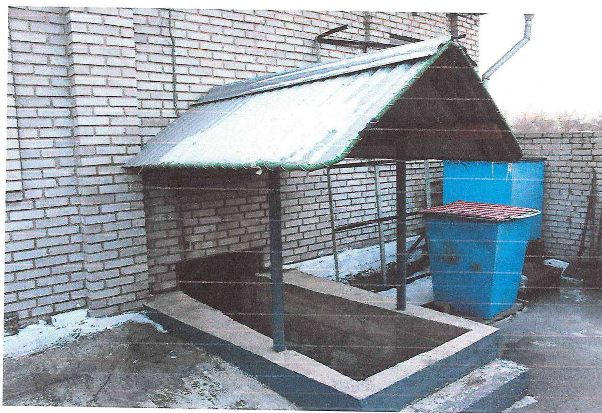
Фото 7. Вход в подвал.
