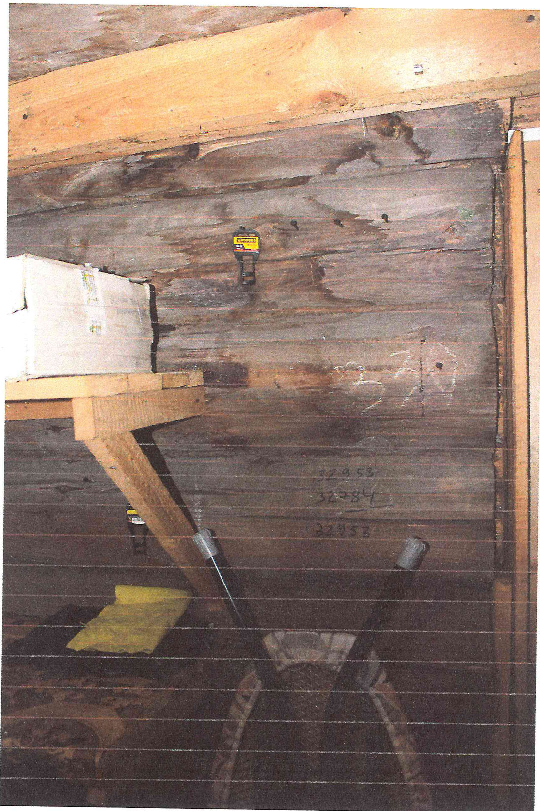
Фото 14. Фрагмент бревенчатой стены.
